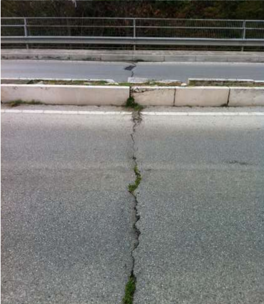
A circa metà del ponte asfalto danneggiato causa verosimile cedimento strutturale
