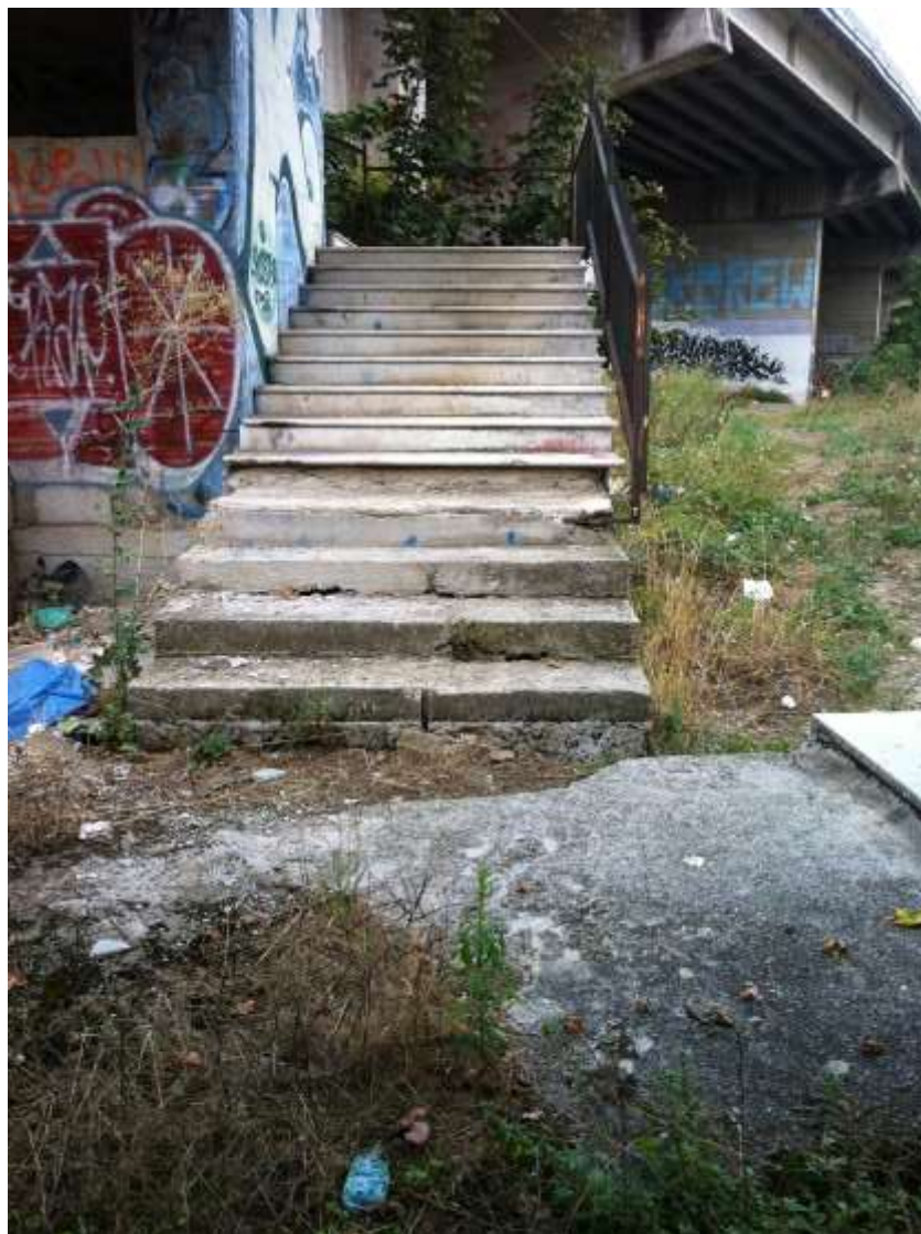
Ponte nei pressi della scaletta laterale che dà su Parco Tre Fontane, ferri fuori cemento
