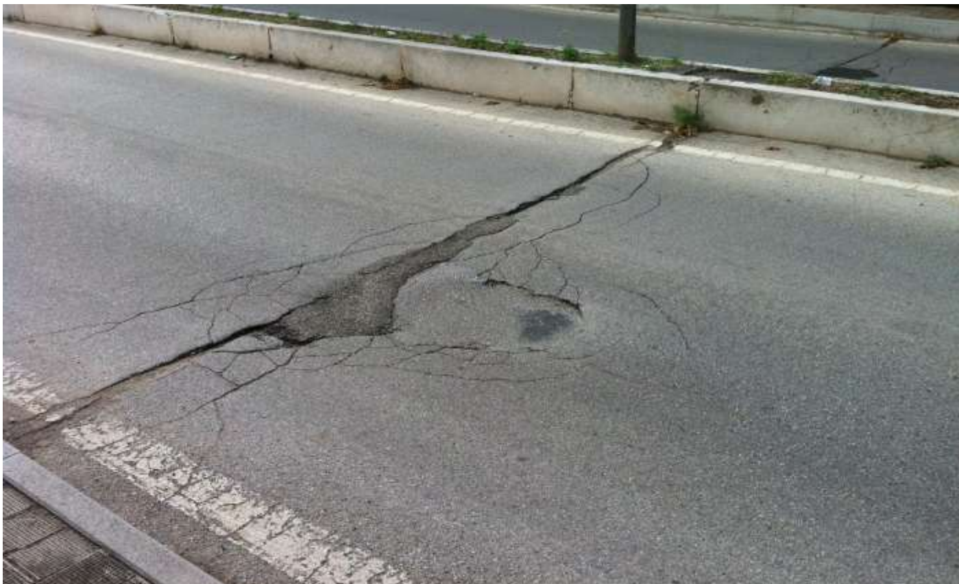
Ponte nei pressi della scaletta laterale che dà su Parco Tre Fontane, asfalto danneggiato e verosimile cedimento del piano strada su intera carreggiata
