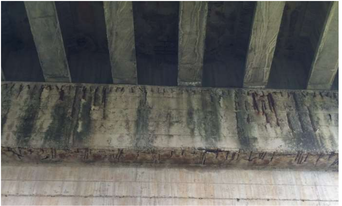
Pilone pressi scaletta laterale che dà su parco Tre Fontane, ferri faccia a vista fuori cemento
