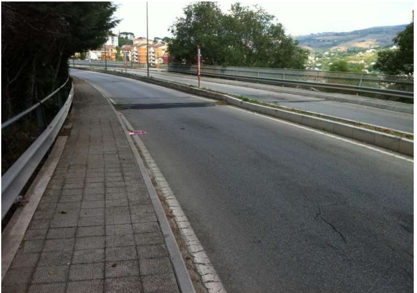
Ponte da rampa accesso Rione Francioso, al verosimile cedimento strutturale piano strada una striscia di asfalto per l'intera carreggiata occulta e tende a "livellarne" il piano
