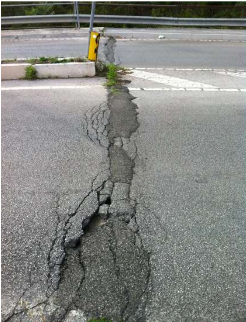
Rampa Rione Lucania, asfalto danneggiato per intera carreggiata su giunti in stato comatoso
