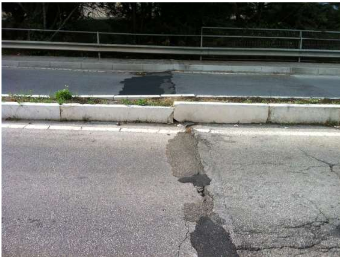
Ponte nei pressi della scaletta laterale (controcampo) verosimile cedimento del piano strada su intera carreggiata: si osservi dislivello e taglio marmo della mezzeria. Per occultare il dissesto è stato posto sul manto stradale dell'asfalto teso a "livellare" il piano strada
