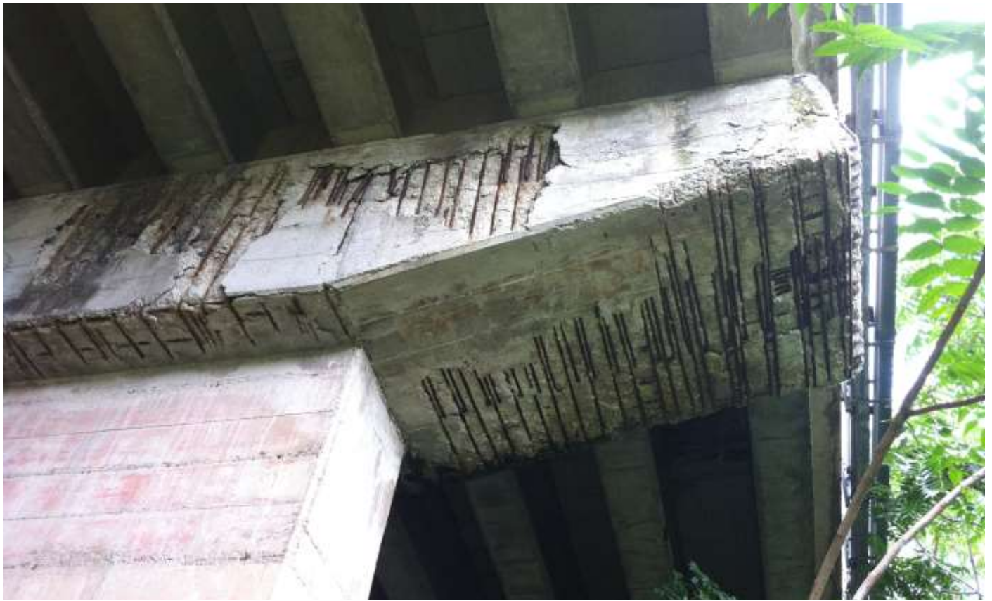
Ferri faccia a vista fuori cemento
