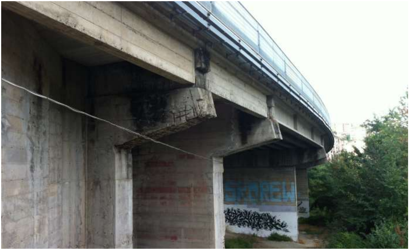
Ponte nei pressi della scaletta laterale che dà su Parco Tre Fontane, ferri fuori cemento
