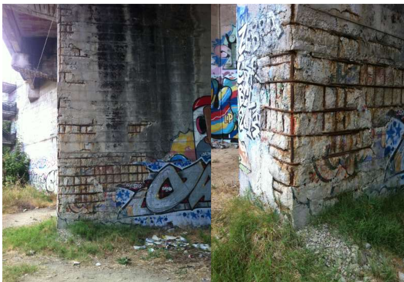
Pilone pressi scaletta laterale che dà su parco Tre Fontane, ferri faccia a vista fuori cemento
